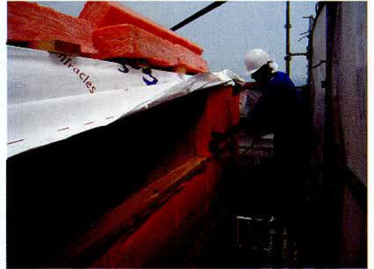
壁の付加断熱の納まり。写真はグラスウール厚100mmの付加断熱。軸組に構造用合板を打ち付け、そこに横桟を打って断熱材をはめ込んでいる。この外側に透湿防水シートを張り、縦胴縁を打って通気層を設ける
